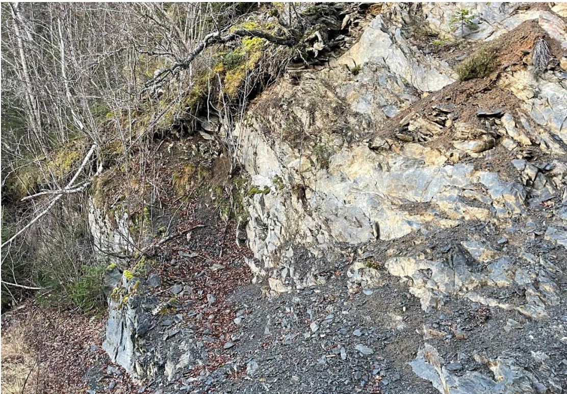
Foto 3-4: Siltstein der øvre lag av overflateforvitret berg er gravd av. Berget er mindre flisig og har noe lavere oppsprekingsgrad enn avgravd bergmasse. Bildet er tatt ved prøvelokalitet 61 ved ca. profil 11 200. (Kilde: Norconsult).
